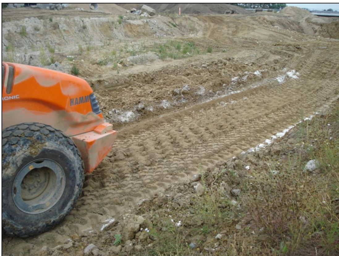
Kalkstabiliseret jord efter komprimering.
