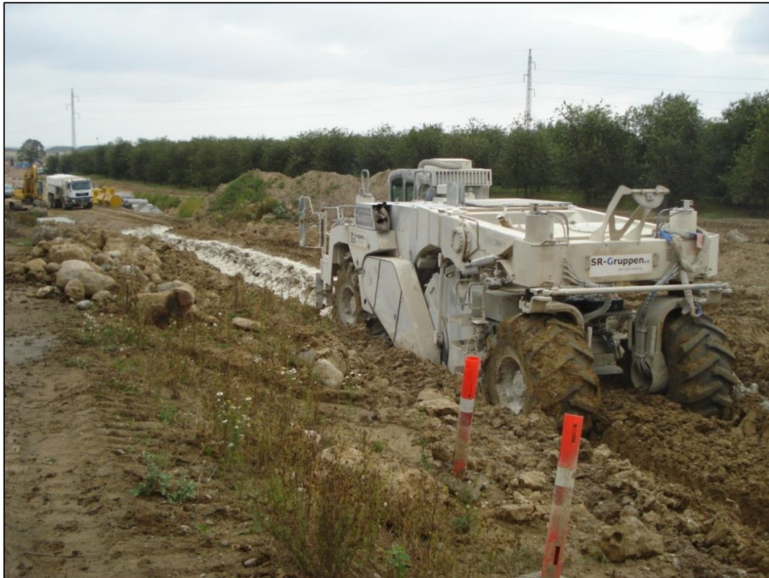
Jorden fræses efter at kalken er udlagt.
