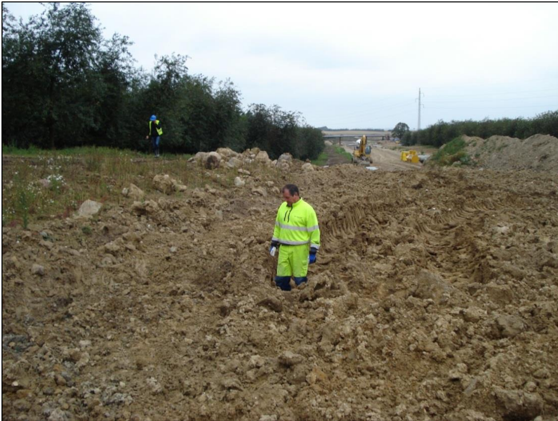
Våd siltet lerjord med ringe bæreevne.
